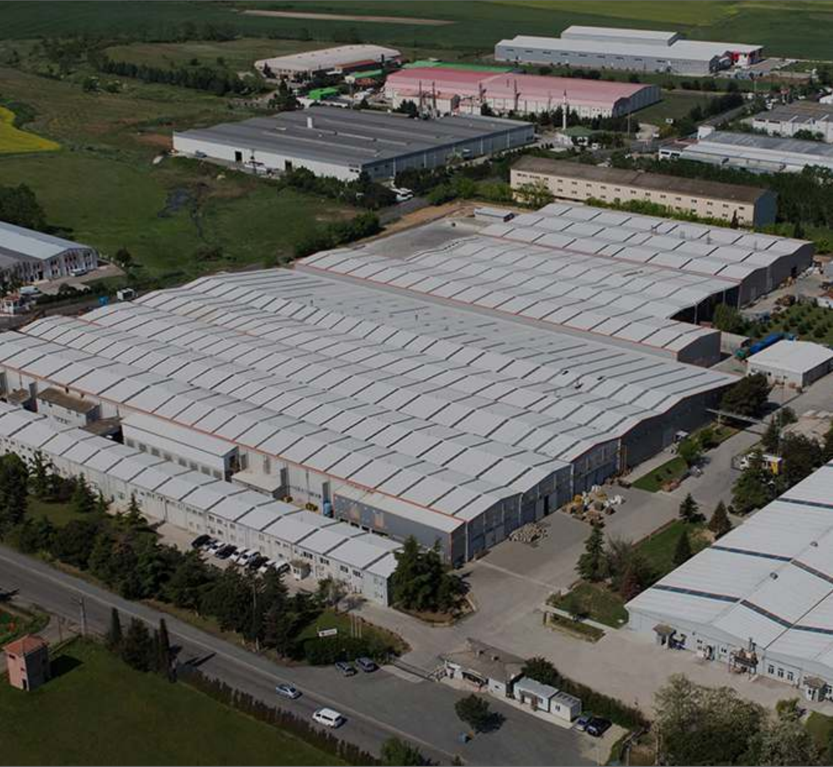
Termo Teknik Çorlu Üretim Tesisleri
